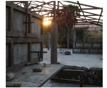
Die Werkstatt im Bau
