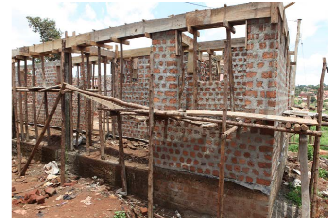
Bei unserem letzten Besuch wurde an einigen Stellen noch gebaut
